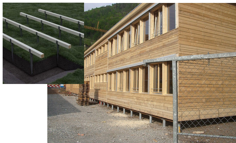
2-3. ábra Talajcsavaros építési lehetőség
